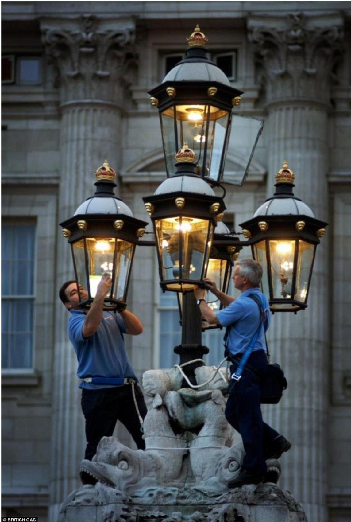
**Fig.75a– Vista de um dos lampadários instalados no alto dos pilares dos portões principais do palácio de Buckingham, Londres, Reino Unido, passando por cuidados de manutenção. Criados por William Sugg Co. em 1901, ainda se mantêm alimentados a gás. Foto @ *British Gas*,c. 2014.**
