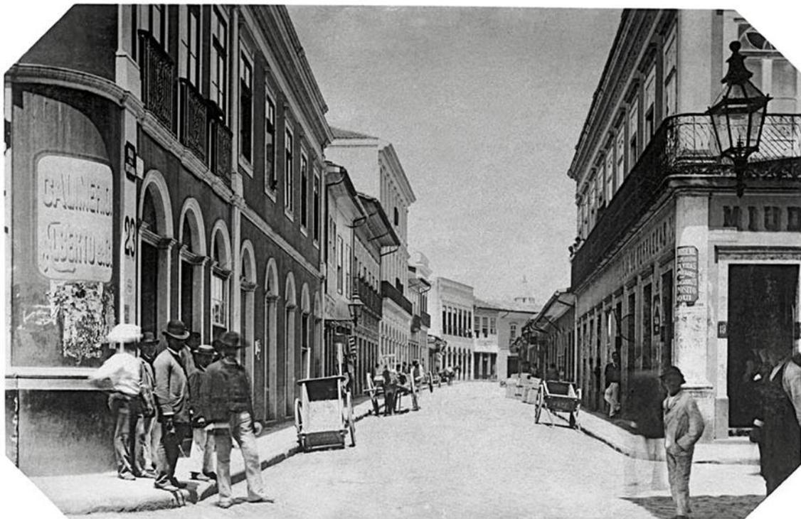
**Fig.58b - Vista da rua da Quitanda em 1887. Foto de Militão de Azevedo. À extrema direita, ao alto, na esquina, lampião a gás com teto de vidro sobre de braço de ferro fundido, adotado a partir dos anos 1870.**
