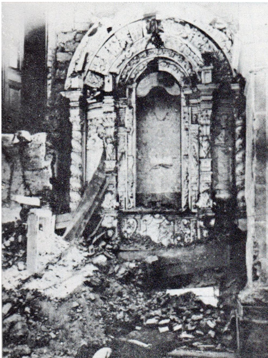
Fig.20- Vista da segunda capela do Evangelho, com seu arco levado ao chão. No canto superior à esquerda da imagem, vê-se a porta interna que, a partir do pavimento superior, dava acesso a um dos dois púlpitos instalados no interior da nave. Foto de Pedro Hoenen, 1896.
