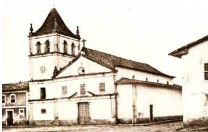
Fig. 2- Aspecto do Pátio do Colégio, por volta de 1862/1863. Notando-se o acréscimo lateral da igreja e os quatro óculos polilobulados executados durante a reforma de 1741-1745.
