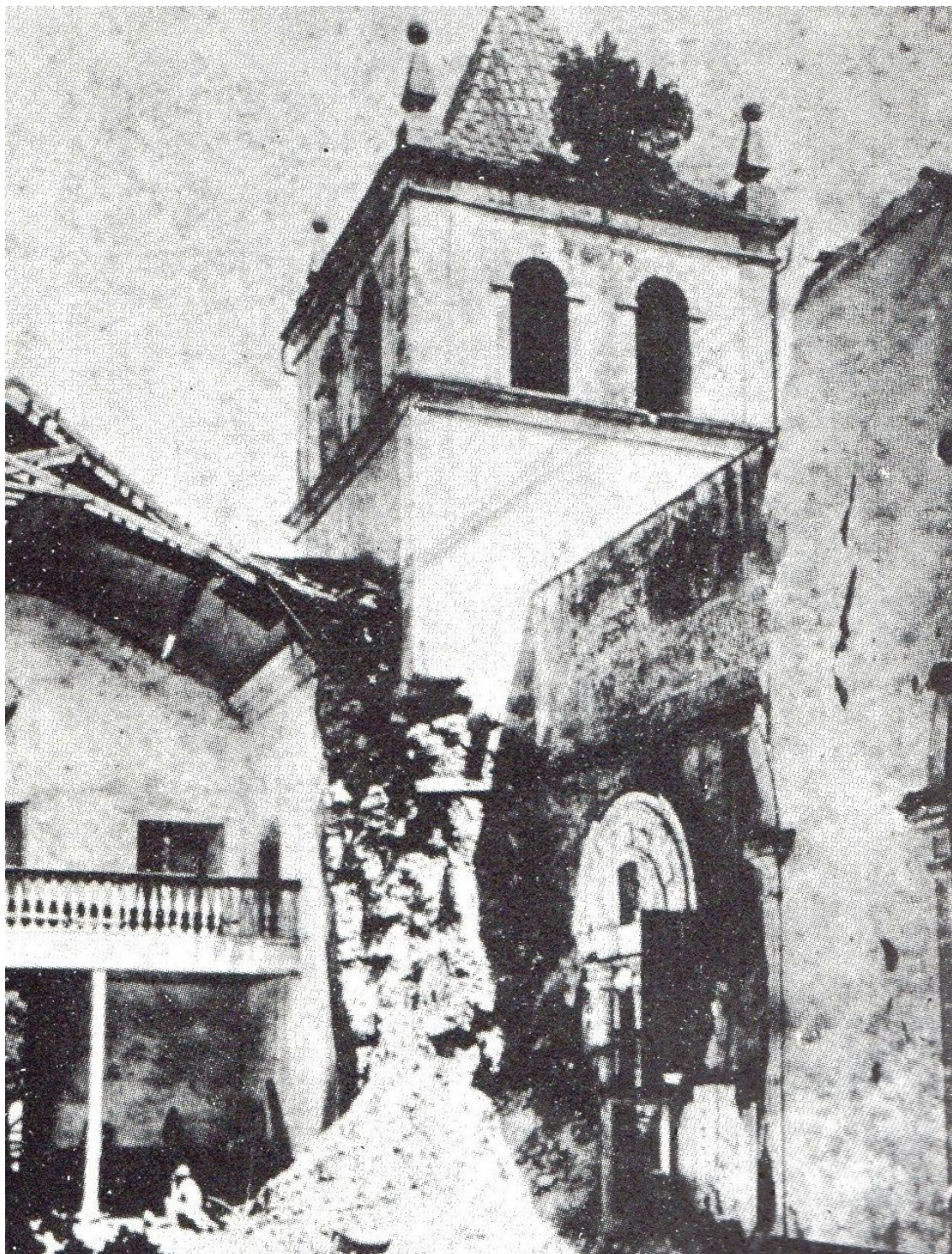
Fig. 19- Aspecto interno da antiga igreja do Colégio, com a objetiva do fotógrafo direcionada para o lado do Evangelho. Segundo se averiguou, o desmoronamento da igreja iniciou-se a partir do canto da torre, provocando o arriamento do telhado e a destruição dos arcos de duas capelas e um dos púlpitos. Na terceira capela do Evangelho, junto à torre, é possível discernir, encostado contra a parede, um dos retábulos mais antigos da igreja. Foto de Pedro Hoenen, 1896.
